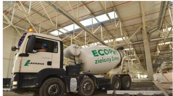
Rys. 2. Betoniarzka firmy Lafarge z „zielonym betonem” (źródło: domena publiczna).
